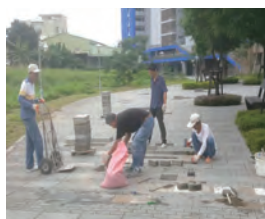
▲ 信實廣場鋪面施作工程
