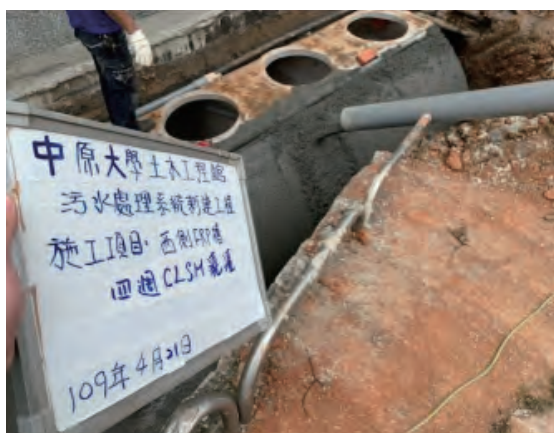
▲ 土木館西側污水槽 CLSM 澆灌
